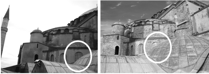
図1 西側外壁の漆喰除去前と除去後（左：2006年11月，右：2011年9月）
