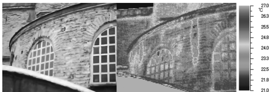
図10 第2コーニス北西部の可視画像（左）と熱画像（右）（口絵参照）
