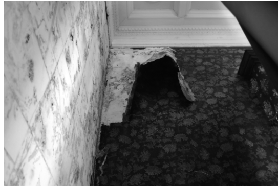
図14 貴賓室の金唐皮紙の東面の剥離（2011年4月10日撮影） （北面：写真の左側は金唐革紙が全面剥離）
