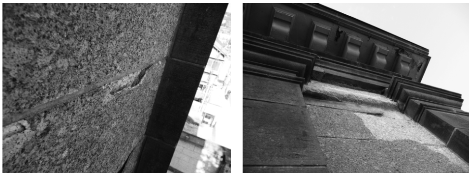
図5 東面（北面角）の軒蛇腹直近の小樽軟石の剝落と界面剝離（2011年10月28日撮影）
