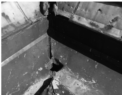
図10 西側の屋根と雨樋上部周辺の腐食(左)と軒天井で見られる破損(右) (2010年7月13日撮影)
