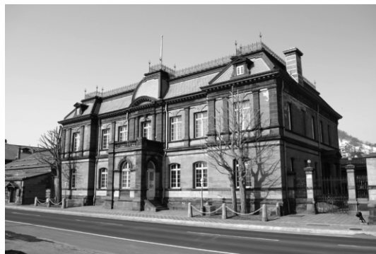
図1 旧日本郵船の全景（2010年4月10日撮影）
