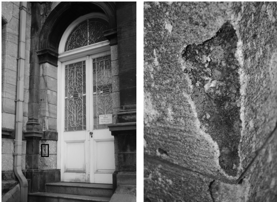
図4 東面の腰蛇腹直近でみられる小樽軟石の劣化（2010年4月3日撮影） ※右図：左図の□の拡大で、白く見える部分がシリコン樹脂の含浸域
