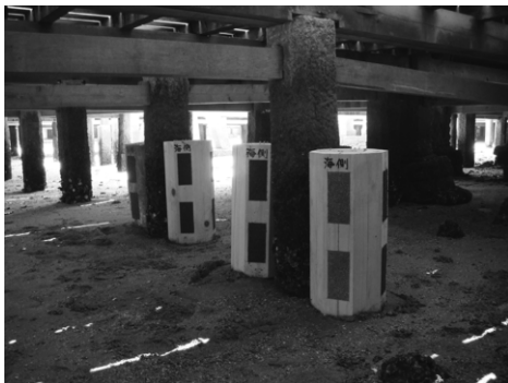
写真7 現地曝露試験 試験体1の設置
