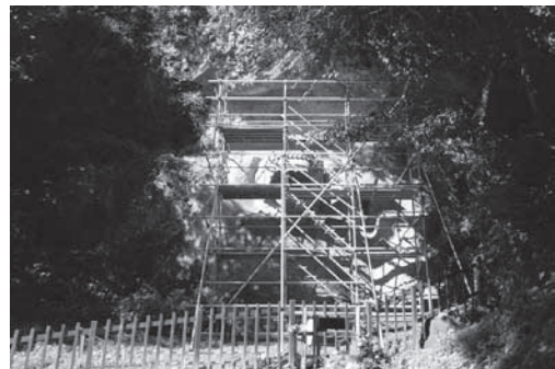
写真1 大日如来像作業足場
