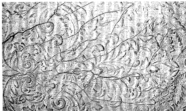
写真5 壁紙④, 断片 (2階北隅室)
