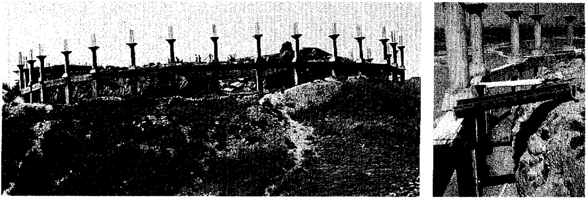
図 15 遺跡の周りに建てられた鉄筋コンクリート柱 (遺跡を掘り込んで下部で連結されている)
