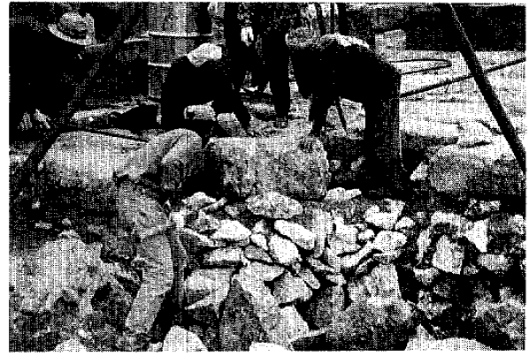
図 20 奥室床面の嵩上げ作業
