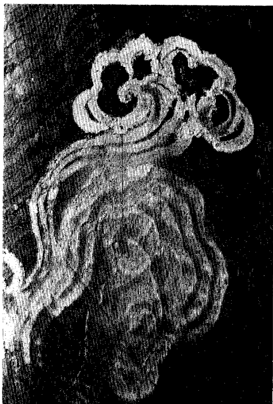
図一15 支輪板(B) 湧雲(下部緑青塗りの剥落部分)
