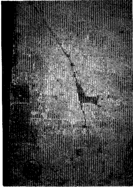
図-21 二条城 日の当たる所にある障壁画の亀裂
