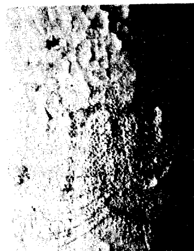
図-4 剥離及原因不明の細かい凸起の集団 東北柱 南側
