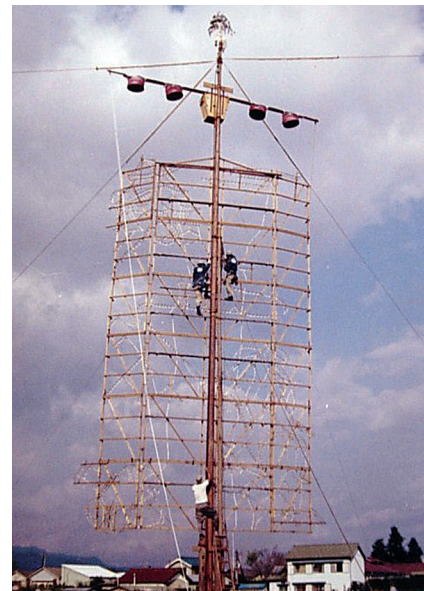
写真 27 当時はすべての作業を人力で行った。 背板を金具で止める作業も人が親柱 に上って行った。
