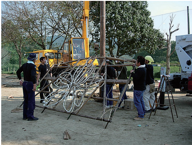
写真9 親柱に背板を取り付ける。背板は上部から順番に上げる。
