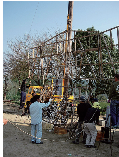
写真10 中心の背板と両脇の開閉状になる背板は金具で繋いでから引き上げる。
