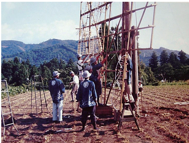
写真 26 平成元年までは畑の中で立物花火を行っていた。地上に 親柱を立てるため、「小坊主」という親柱より小ぶりの 木を軸にした。
