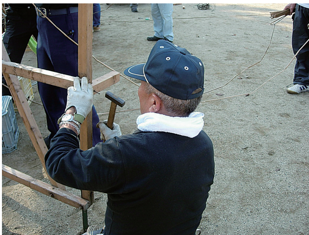
写真11 両脇の背板を閉じた場合、中心の背板と左右の背板のランスがぶつからないよう、「ネコ」と呼ばれる木片で厚みを出す。
