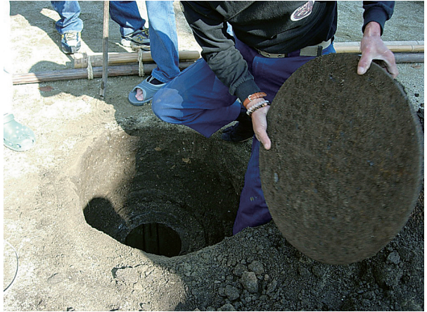
写真8 地面から40センチ下にマンホールのような鉄板があり、その下に親柱を固定するためのヒューム管が埋め込んである。
