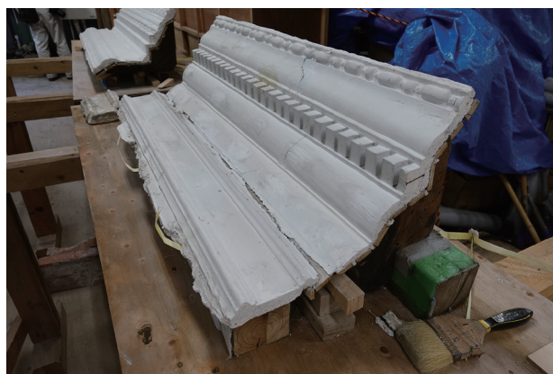
写真10 大バラシによって解体された漆喰蛇腹 [撮影：筆者]
