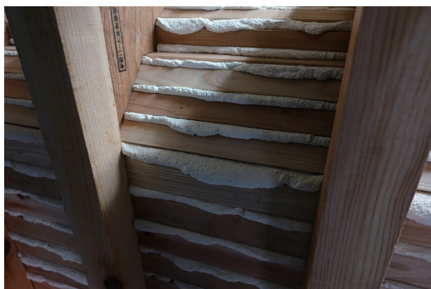
写真9 組んだ木摺への施工実験 [撮影：筆者]
