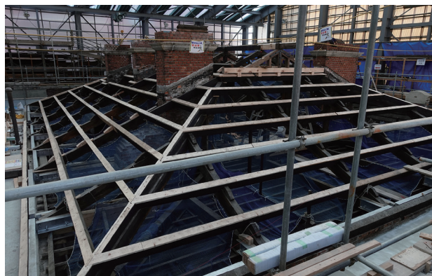
写真7 保存修理工事中的の様子 [撮影：筆者]
