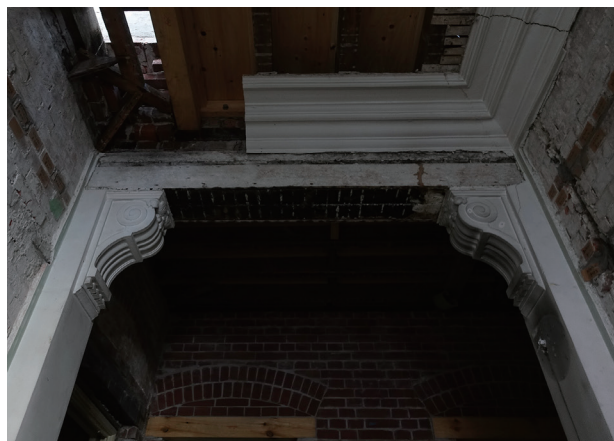
写真8 解体修理中の漆喰装飾 [撮影：筆者]
