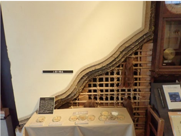
写真 八日市・護国町並保存センターの展示（土壁の内部構造を使用材料と共に展示している）
