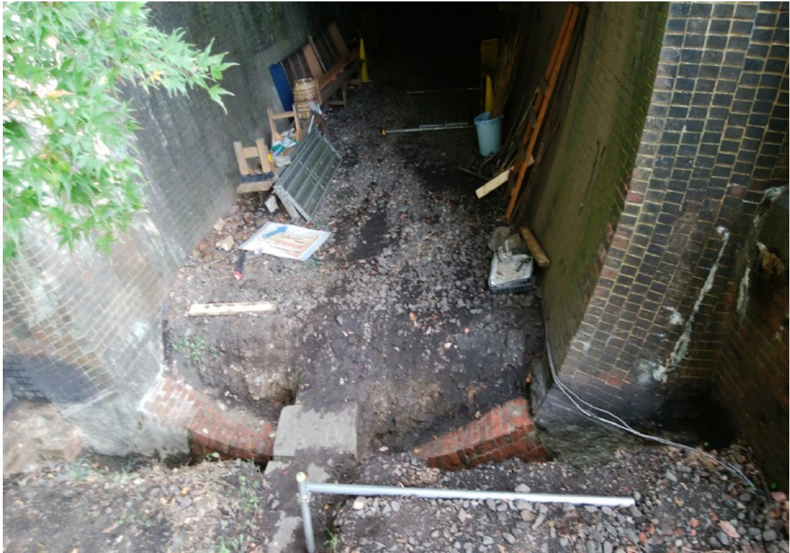
写真2 インバート発掘風景
