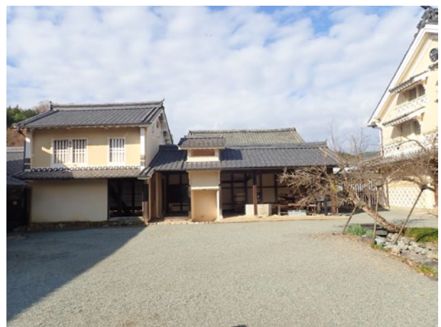
写真 上芳我家住宅正面（中庭から製蠟施設を望む）
