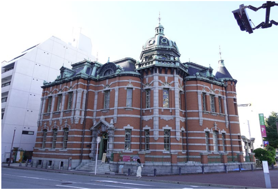
写真 旧日本生命保険株式会社九州支店（福岡赤煉瓦館）全景
