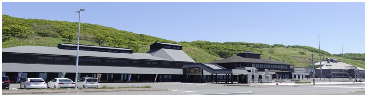
写真 道の駅全景（右奥に旧花田家番屋が位置する）
