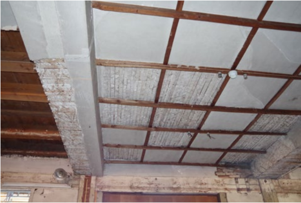
写真5 西置繭所1階木摺漆喰塗天井（着工前）
