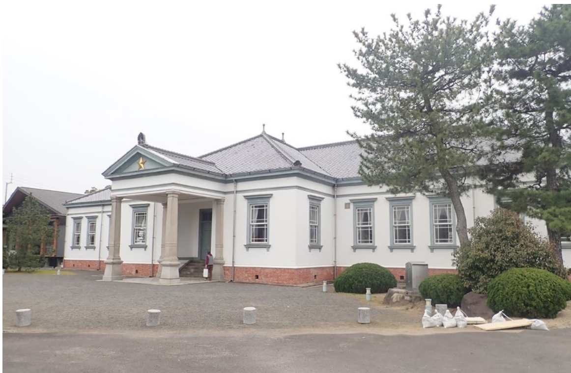
写真 旧善通寺偕行社（左奥が附属棟）
