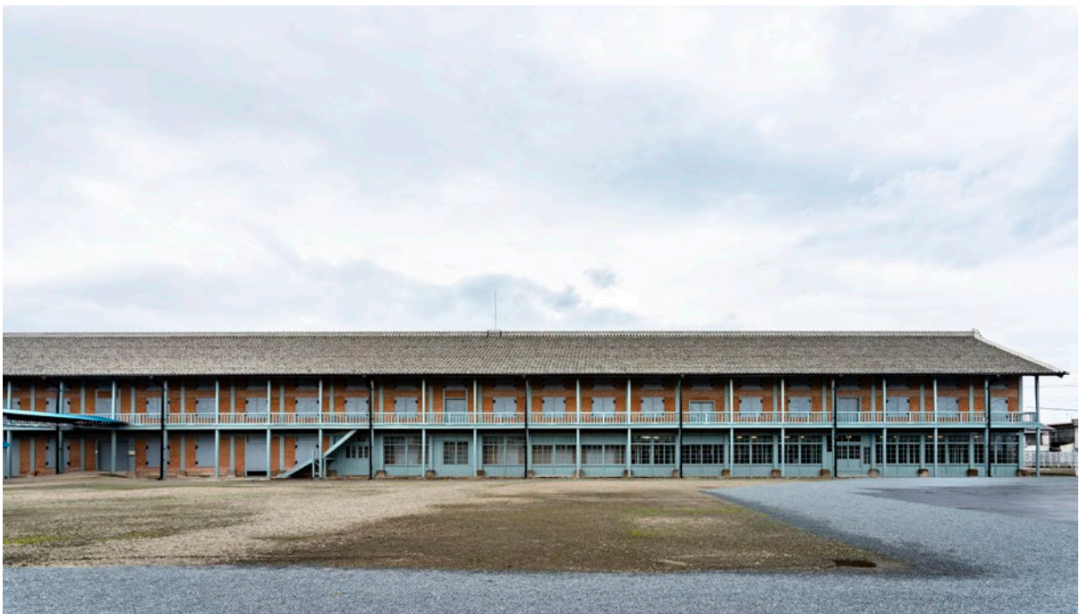
写真1 西置繭所外観(工事完了後) / 撮影: 瀬脇 武
