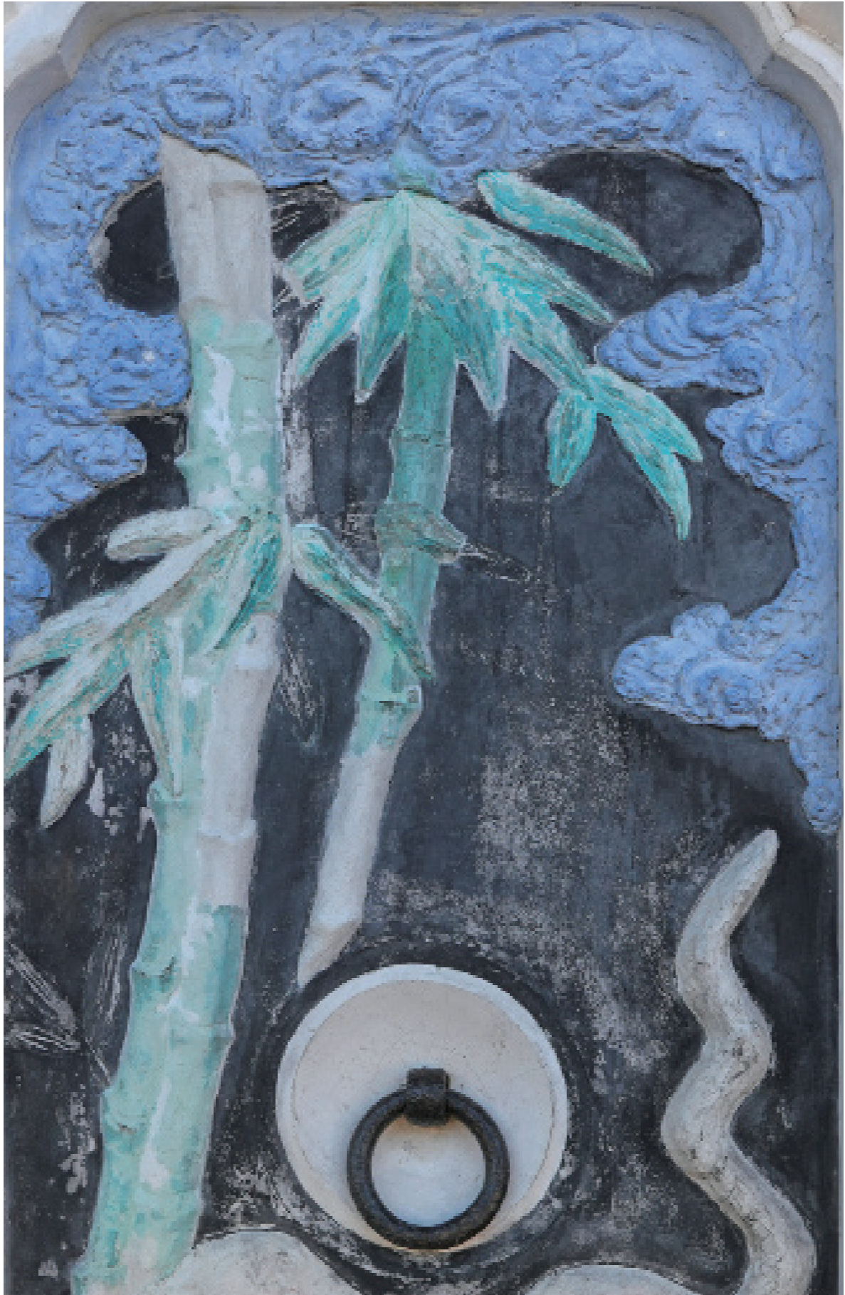
写真 26 剥落箇所の復元充填
