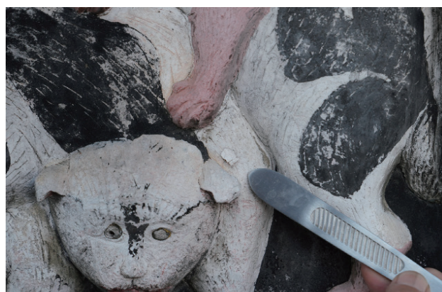
写真7 釘の周辺で発生した漆喰の剥離（犬と牡丹）
