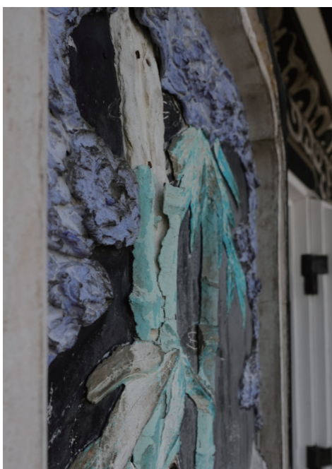
左 写真8 仕上げ層の剥離・剥落
