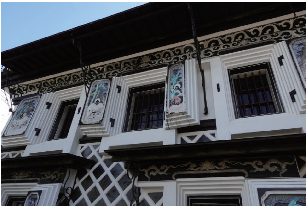
写真 1 旧機那サフラン酒製造本舗土蔵外観（北面）
