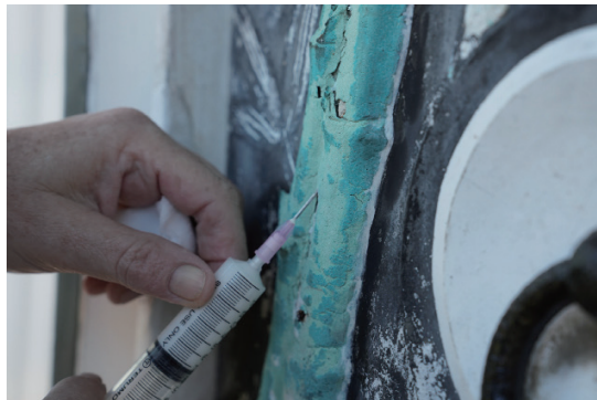
写真23 注射器による充填材の注入
