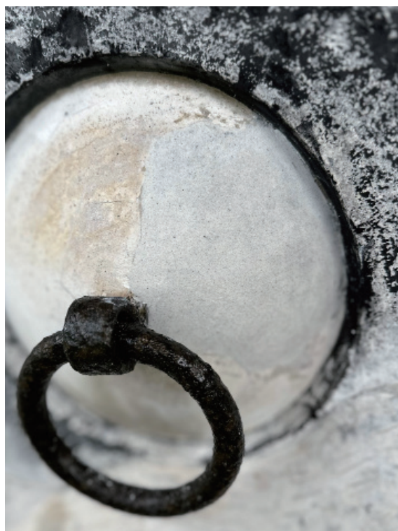
写真27 過去の修理箇所への充填処置手順
