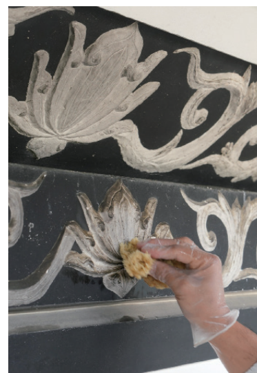
写真 17 ウェットクリーニングの様子
